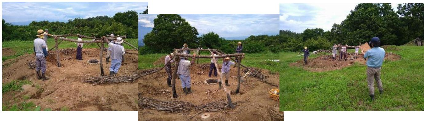
柱の下部に虫食いによる腐食が見つかったため、柱を20cmほど短くせざるを得ません。するとその分高さも下がることになりますが、柱の埋め込み部分を浅くし、さらに床面を少し掘り下げることにより以前の屋根の高さを維持する予定です。仮に置いた梁に垂木を置いてみて屋根の勾配を確認。また新たに開発した？南さん作成の分度器が登場。4号棟の屋根の勾配に比べて、3号棟の屋根の傾斜が急であったことを考慮して、35度から30度程度の傾斜角にし、垂木あまり土に埋めない方法で腐食対策をおこなうことを検討しています。
