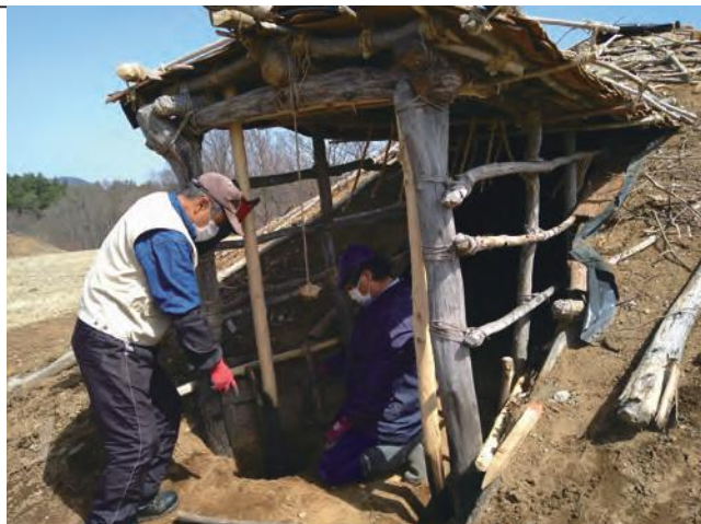
扉取り付け用の柱を設置
